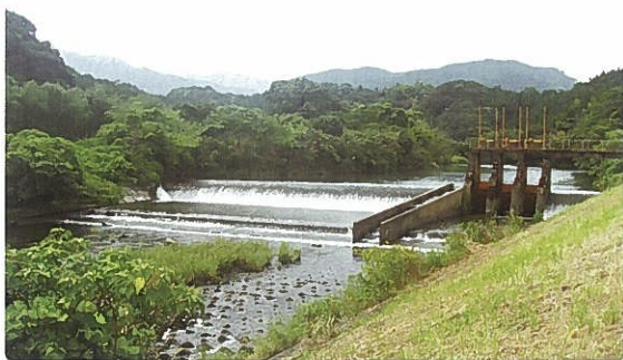
田布尾堰の全景
