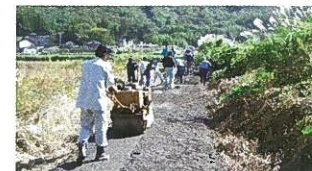
未舗装の農道を アスファルトで舗装
