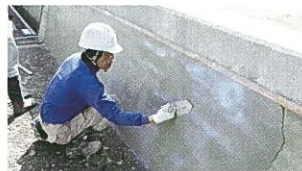
老朽化した水路壁の コーティング
