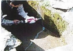
水路のひび割れ補修
