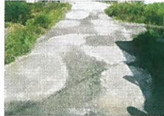
農道の窪みの補修
