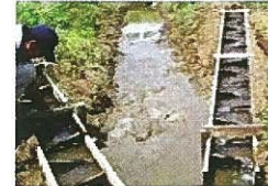
水田魚道の設置
