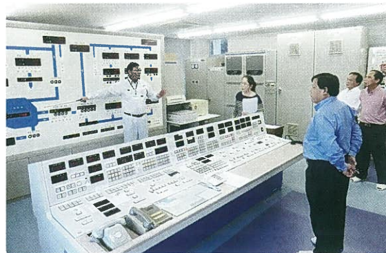
南薩土地改良区の中央管理所を視察
