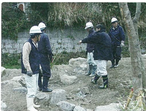
写真-3 直営施工の状況
